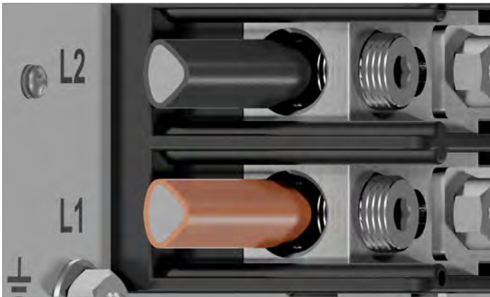
Korrekte Lage von sektorförmigen Aluminiumkabeln (2)
